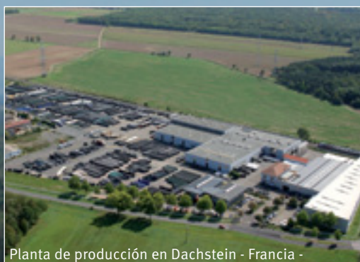
Planta de producción en Dachstein - Francia -
