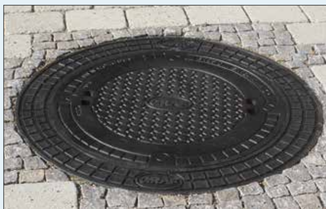
Cubierta telescópica transitable por vehículos
