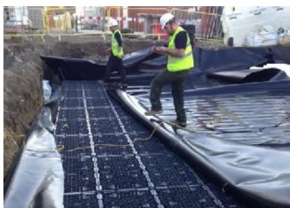
Elementos que conforman el sistema de contención o atenuación ECOBLOC GRAF
